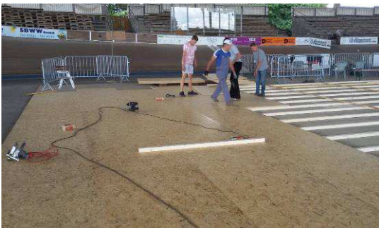
Einbau der Trainingsfläche im Radstadion
